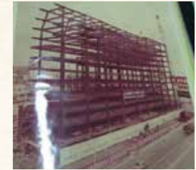
建設中の琉球リースビル
