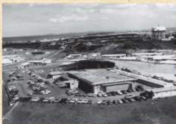
まちのシンボルとなる配水タンクが確認できる/那覇市歴史博物館所蔵
